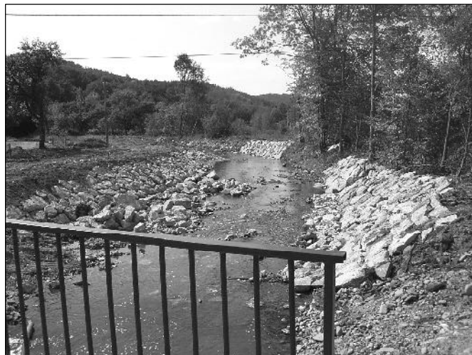
Oprava koryta potoka Bystřička
